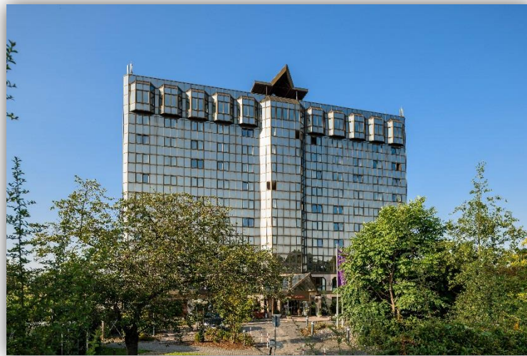
Außenansicht Mercure Hotel Koblenz
